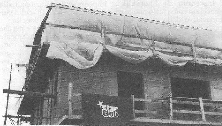
La sede dello Starclub in fase di allestimento
