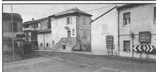
Sistemazione incrocio e strada per Caprara.
