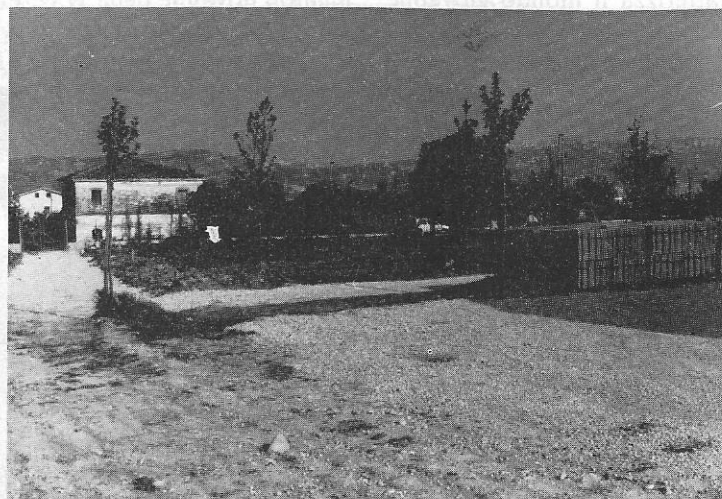
Cerratina. Il parco in costruzione
