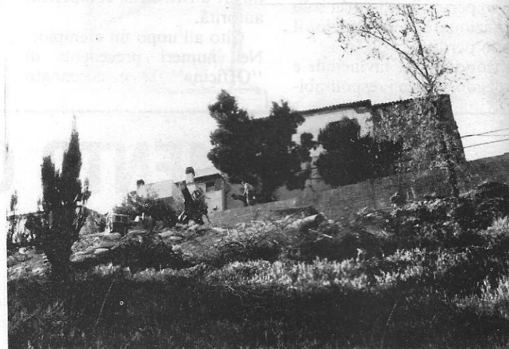
Pianella. I lavori per la frana
